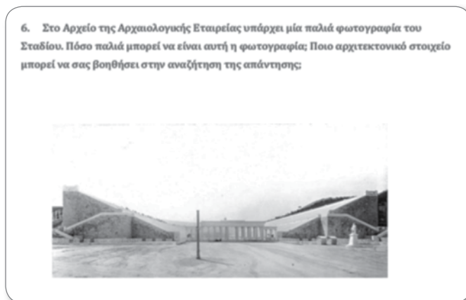
Εικόνα 6. Άσκηση για την κατανόηση του χρονολογικού συστήματος.
